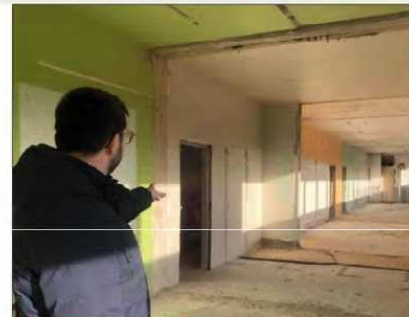
VITTEL Le stade Bouloumié en travaux devrait rouvrir en 2024
